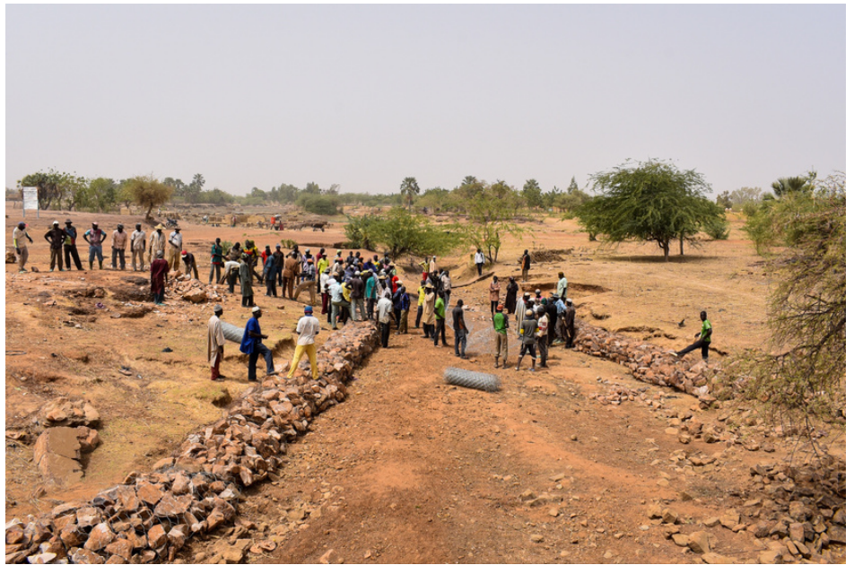
Aménagement de barrages filtrants et de berges pour le contrôle de l'érosion. Photo:PAM/Benoit Lognone
