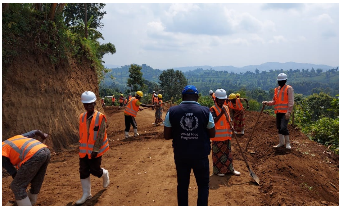
Membres de la communauté effectuant des travaux de remise en état d'une route dans le Nord-Kivu. Photo: PAM/Équipe d'ingénierie du bureau de pays
