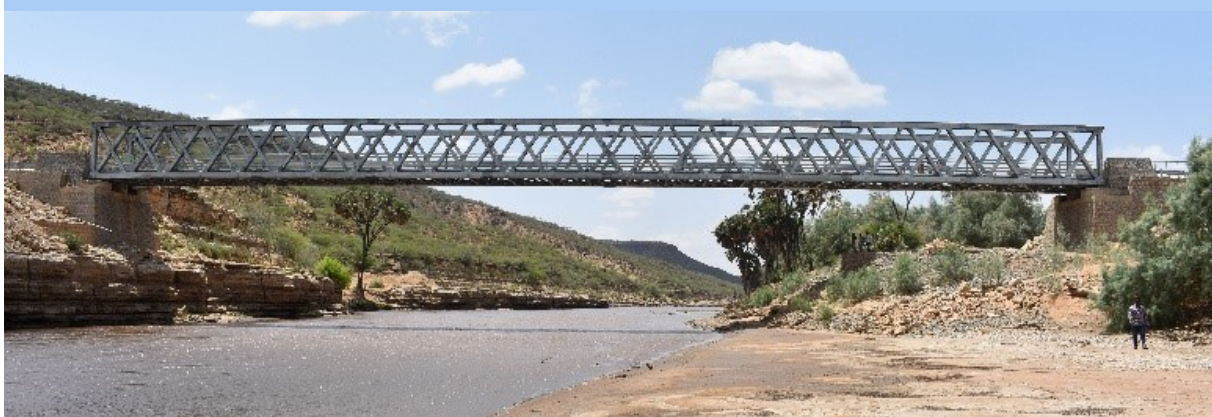
Le pont de Geeldoh une fois la construction achevée. Photo: PAM/Équipe d'ingénierie du bureau de pays
