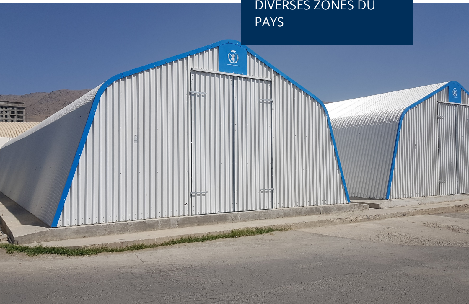
Entrepôts rénovés à Kaboul. Photo: PAM/Équipe d'ingénierie du bureau de pays
