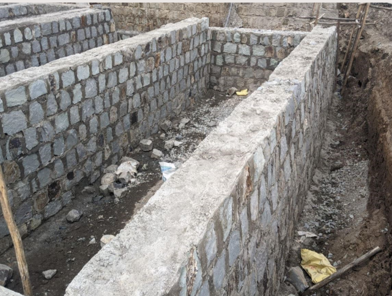
Travaux de construction de l'hôpital d'Eka Kotebe. Photo: PAM/Bureau du PAM en Éthiopie
