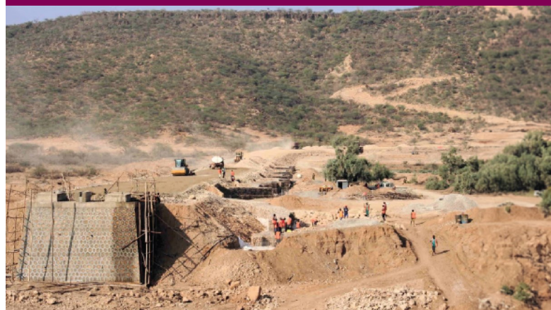
Le pont de Geeldoh, en Éthiopie, en construction. Photo: PAM/Équipe d'ingénierie du bureau de pays
