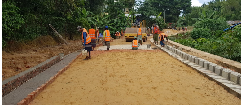
Remise en état de routes à Cox's Bazar.
