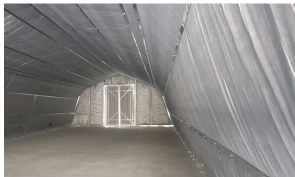
Vue de l'intérieur d'un entrepôt à Kaboul. Photo: PAM/Équipe d'ingénierie du bureau de pays
