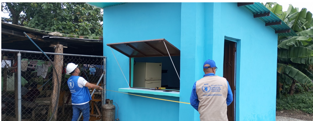
Remise en état de cuisines scolaires au Venezuela. Photo: PAM/Bureau du PAM au Venezuela
