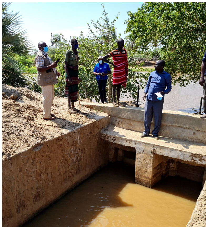
Dispositif d'irrigation de Nanyee, au Kenya.
