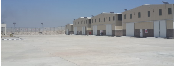
Construction des installations d'aide humanitaire au Pakistan.
