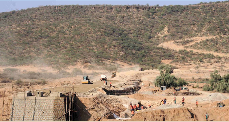
جسر جيلدوه في إثيوبيا أثناء تشييده. الصورة: البرنامج/الفريق الهندسي في المكتب القطري
