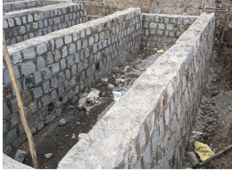
أعمال التشييد في مستشفى إيكأ كوتيببي. الصورة: البرنامج/المكتب القطري في إثيوبيا
